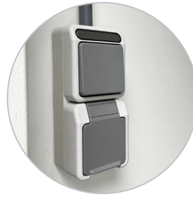
LED-Beleuchtung und Steckdosen
